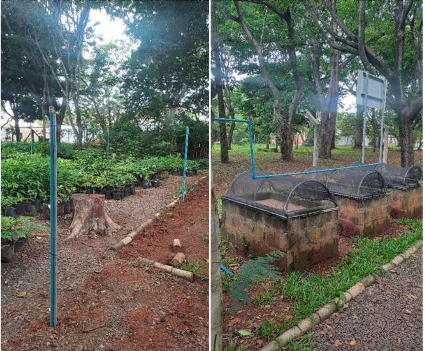
Fotos das estruturas de irrigação sendo instaladas na rustificação e nas sementeiras.
