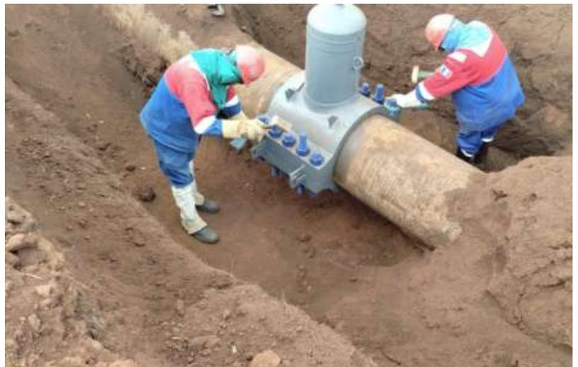
Foto da realização de reparo em duto com ocorrência de vazamento - relatório de ocorrência.
