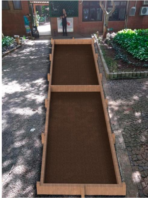
Figura 3 - Imagem ilustrativa do travamento lateral com régua de madeira no local da execução do piso.
